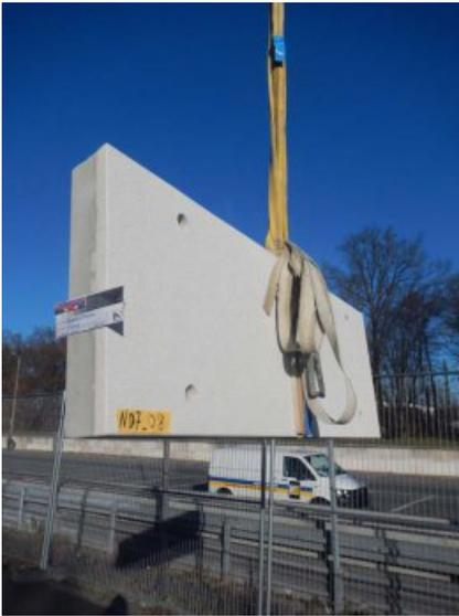
Beim Versetzen der Kunststeinneuteile aus Beton.
