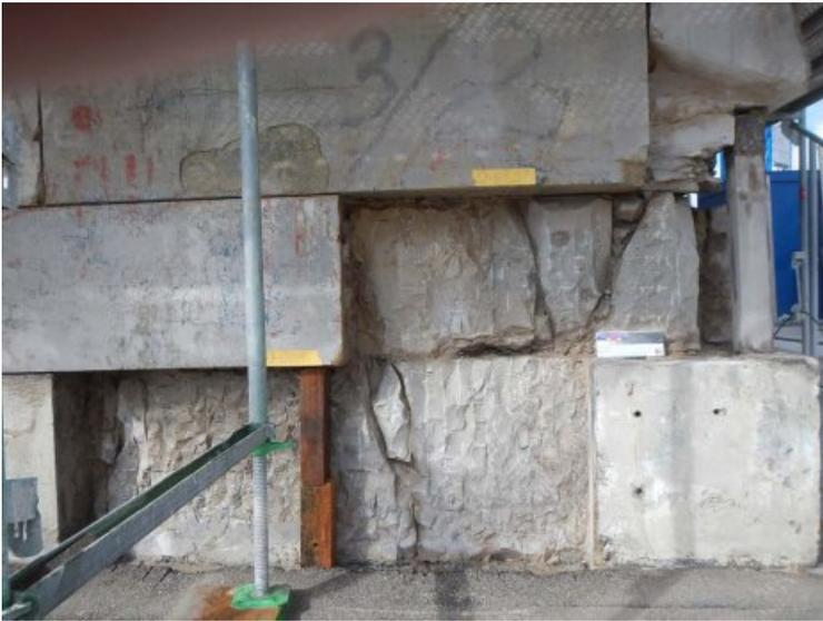
Nach dem Ausarbeiten, die Fehlstellen werden entweder mit Kunststeinplatten oder durch verputzte Ausmauerungen geschlossen.
