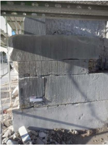
Beim Ausarbeiten defekter Kalksteinwandplatten.
