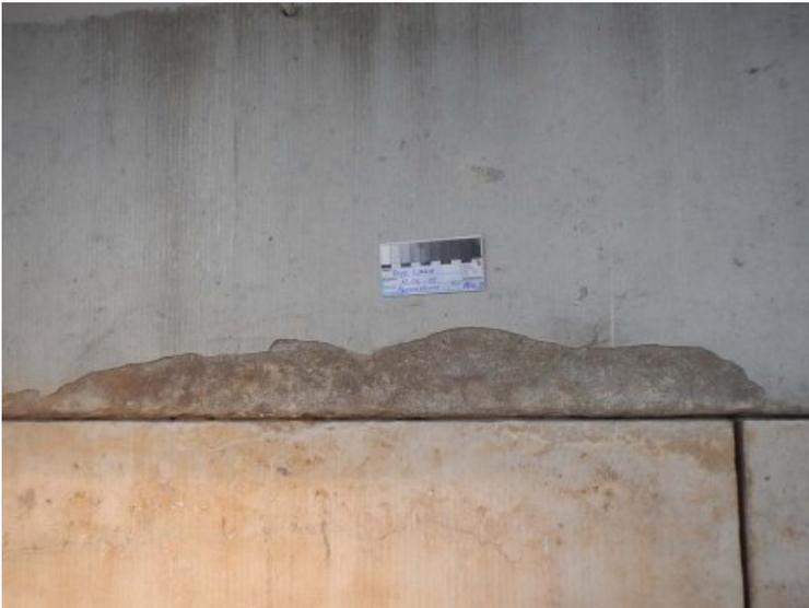
Der Kalkstein weist an der Oberfläche sehr dünne Schalen auf.
