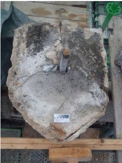
Nach der Demontierung der Wetterfahne wurde die defekte Abdeckplatte abgenommen.
