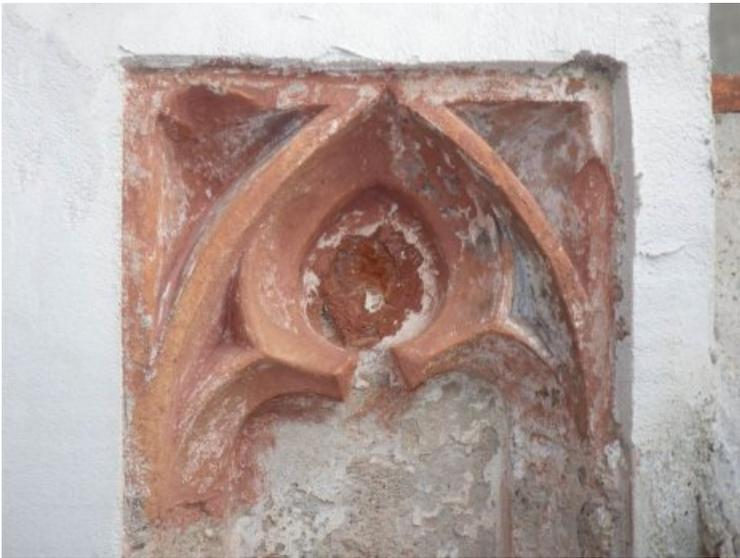
Vorzustand: An der oberen Kante sowie der mittigen Putzrücklage sind Ausbrüche zu sehen.
