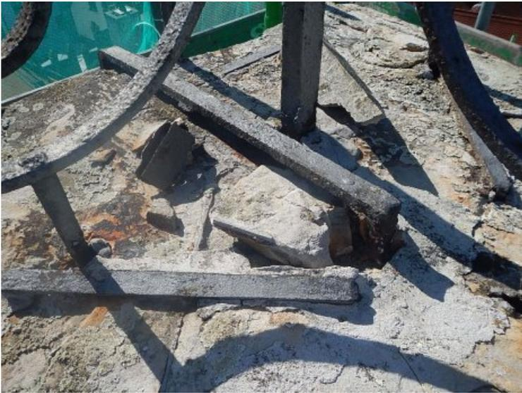
Detailansicht der defekten Metalleinbindung.
