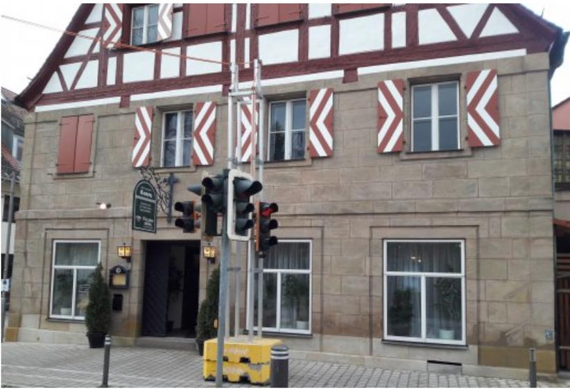
Das Gasthaus während der Restaurierung. Nach Einbau der Sockelplatten, die im Wasserbad salzreduziert worden waren, und Neuteile, Ergänzen von Fehlstellen an Werksteinen und Verfugen.
