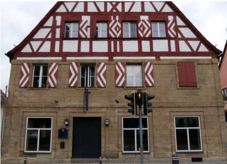
Die Fassade vor der Restaurierung. Insbesondere im Sockelbereich sind Schäden durch bauschädliche Salze zu verzeichnen.
