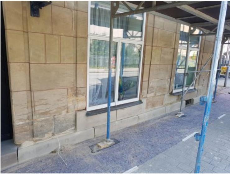
Der Sockelbereich der Straßenfassade während der Bearbeitung. Die jüngeren Sockelplatten wurden zur Salzreduzierung im Wasserbad aus- und wieder eingebaut.
