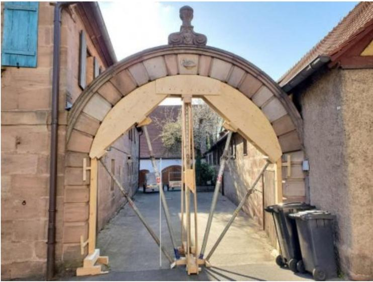
Zwischenzustand: Der beschädigte rechte Torbogen wurde mittels einer angepassten Bogenlehre neu errichtet.
