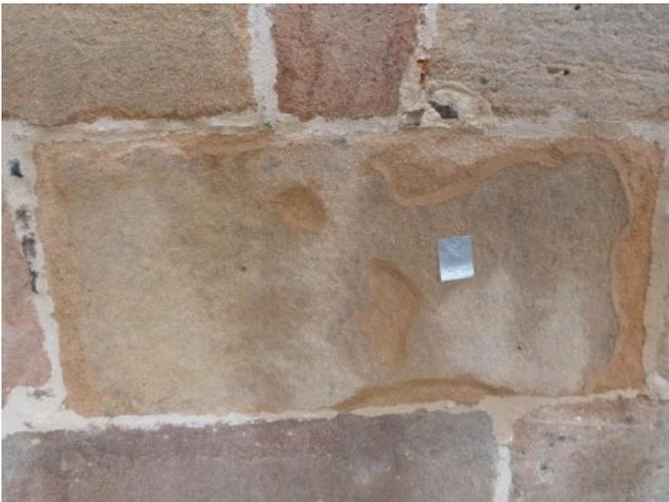
Zwischenzustand: Nach Reinigung und Festigung können Schalenränder mit Steinerfüllungsmörtel angebösch und somit wieder mit der Oberfläche verbunden werden.
