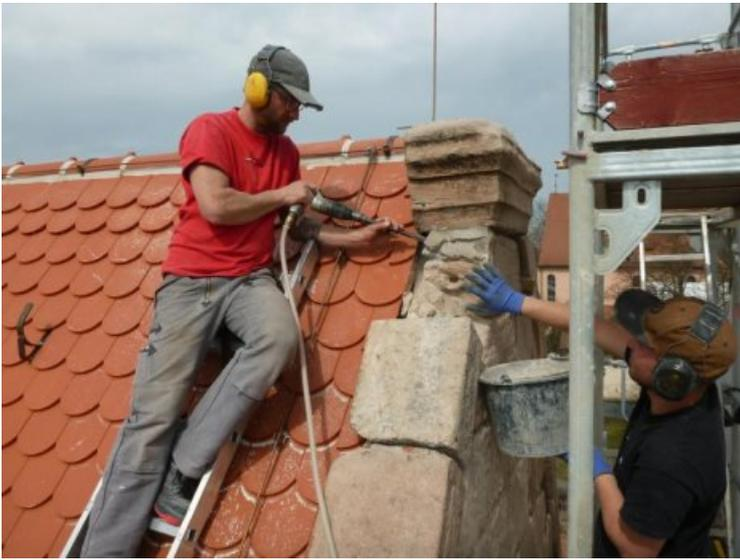
Zwischenzustand: Nicht mehr konsolidierbare Werksteine wurden ausgebaut und ersetzt.
