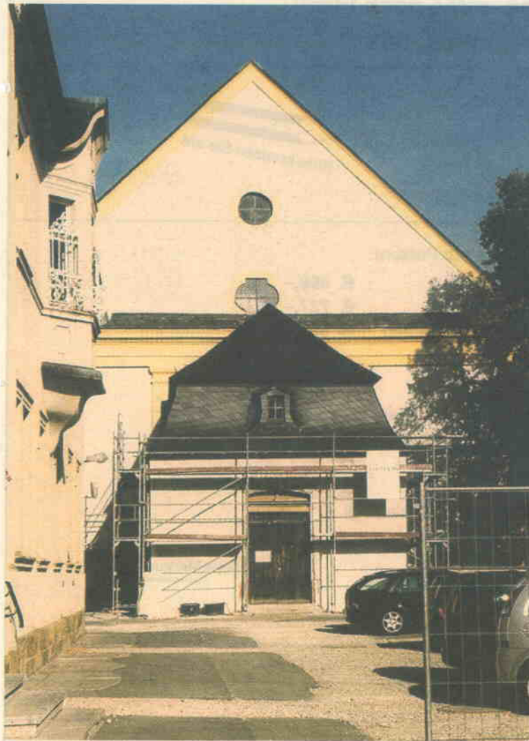
Rechtzeitig zur Einweihung fallen alle Gerüste.
