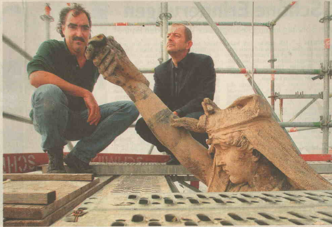
Steinbildhauer Roland Heimbach (links) und Architekt Hermann Keim begutachten die Schäden an der „Else“ auf dem Dach des Stadttheaters. Foto: Hans-Joachim Winckler
