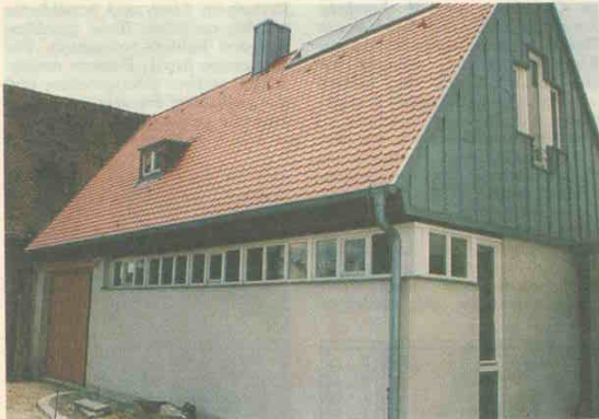
Die neue Sakristei.
