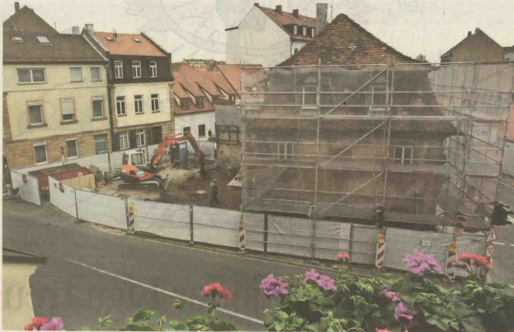
Vom Balkon eines Nachbaranwesens hat man diesen Logenblick auf die Baustelle Nürnberger Straße 2.
