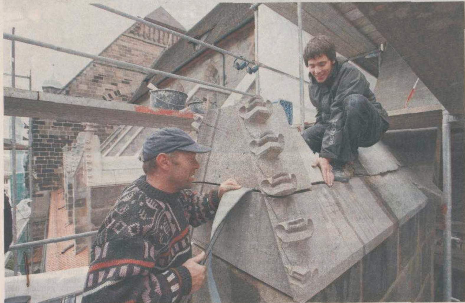
Die beiden Steinmetze Ralf Manz (links) und Jonas Rieger arbeiten an einem sogenannten Wimperg.
