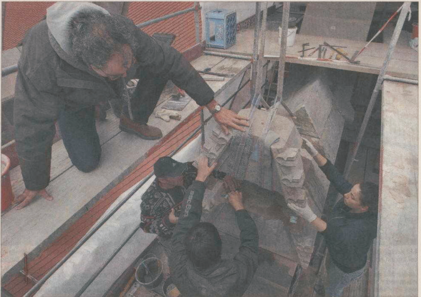
In 18 Metern Höhe, Nordseite der Lorenzkirche: Der mittlere Teil des Wimpergs wird aufgesetzt. Im Bild oben Roland Heimbach, Inhaber der Steinmetzfirma Monolith, unten Mitte Steinmetz Jonas Rieger, der den Wimperg gehauen hat. Foto: Sippel
