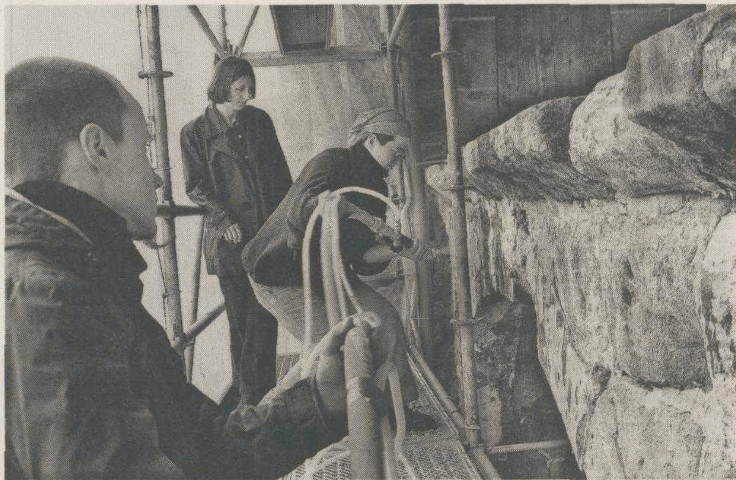
Katrin Wilhelm sprüht an der porösen Maxtormauer Kompressen auf, die das Salz aus den Quadern ziehen sollen.
