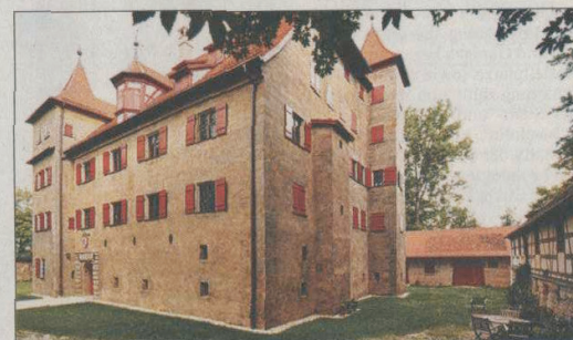
Schloss Haimendorf vor und nach der Instandsetzung.
