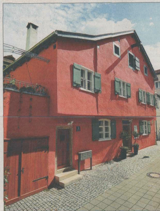
Das ehemalige Kanonikerhaus in der Eichstätter Pfarrgasse vor und nach der Sanierung. FOTOS HYPO KULTURSTIFTUNG
