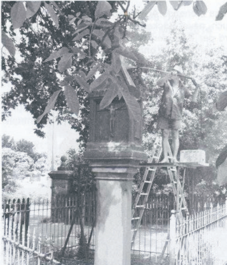
Reinigen der Roten Marter mittels Wasserdampf
