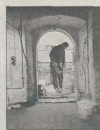
Kellertür zum Regnitzufer.
