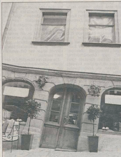
Die schiefe Türe blieb erhalten, die Fassade ist noch nicht fertig; Der in Frescotechnik erstellte Putz erhält seine endgültige Farbfassung wohl erst nächstes Jahr.
