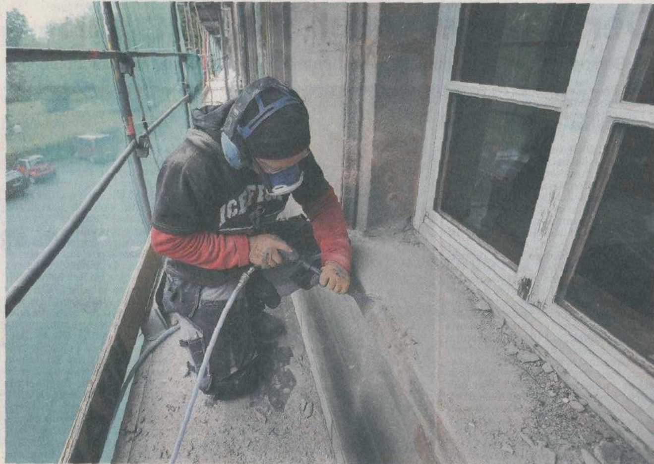
Steinmetzmeister Klaus Becker von der Bamberger Firma monolith bessert die Fenstersimse aus, bevor sie anschließend mit Blech verkleidet werden. Foto: Hans-Joachim Winckler
