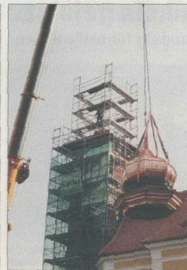
Mit einem Spezialkran wurde die neue kleine Zwiebel auf den Kirchturm gehievt. Foto: privat
