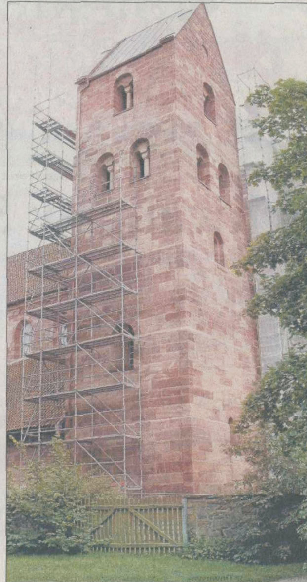
Der Nordturm erstrahlt bereits wieder in neuem Glanz. Links am Turm ist das neue Fallrohr zu erkennen, das nicht dem historischen Vorbild entspricht, von der Denkmalpflege aber erlaubt wurde.
