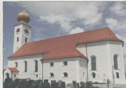
Nach der Außenrenovierung erstrahlt die Vohburger Pfarrkirche St. Peter in neuem Glanz.
