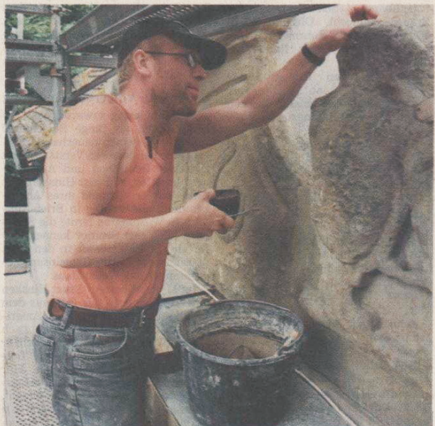
Drei Wochen lang war das Spitaltor gesperrt, weil eine Bamberger Firma Restaurations-Arbeiten durchführte. Nach dem Volksfest erhält das Tor einen frischen Anstrich und neue Fenster. Steinmetz und Restaurator Stephan Weber musste fehlende Stellen ergänzen und den Sandstein festigen.
