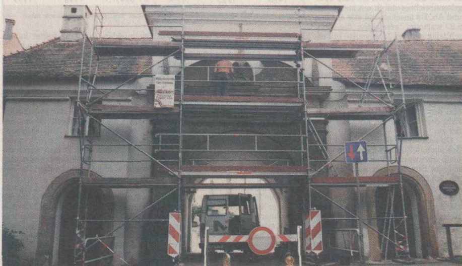
Drei Wochen lang war das Spitaltor gesperrt, weil eine Bamberger Firma Restaurations-Arbeiten durchführte. Nach dem Volksfest erhält das Tor einen frischen Anstrich und neue Fenster. Steinmetz und Restaurator Stephan Weber musste fehlende Stellen ergänzen und den Sandstein festigen.
