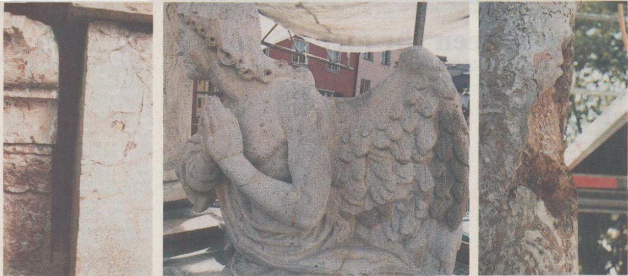
Fünf Zentimeter liegen zwischen der Überdachung der Seitenflügel und dem Sockel der Dreifaltigkeitssäule (Bild links). – Bei näherer Betrachtung werden auch die Schäden am 1984 notdürftig zusammengefügten Engel deutlich. (Mitte) – Wird im kommenden Jahr ausgebessert und mit Acrylharz behandelt: Eine schwerbeschädigte Tragesäule aus Marmor.
