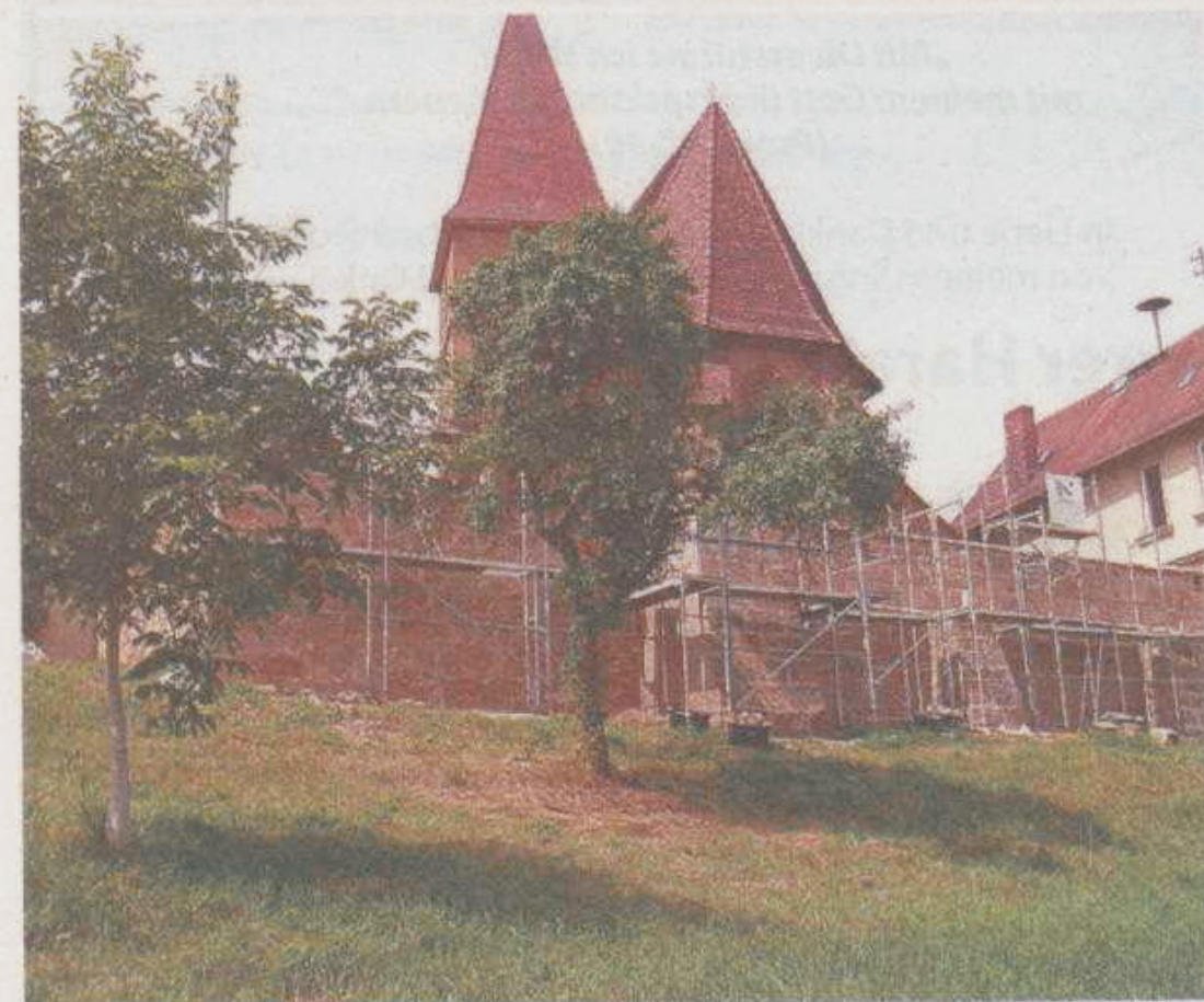
Die Sandsteinmauer während der Sanierung.
