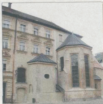
Die Südseite von St. Kassian ist teilweise in das Nachbargebäude miteinbezogen. Foto: Detter
