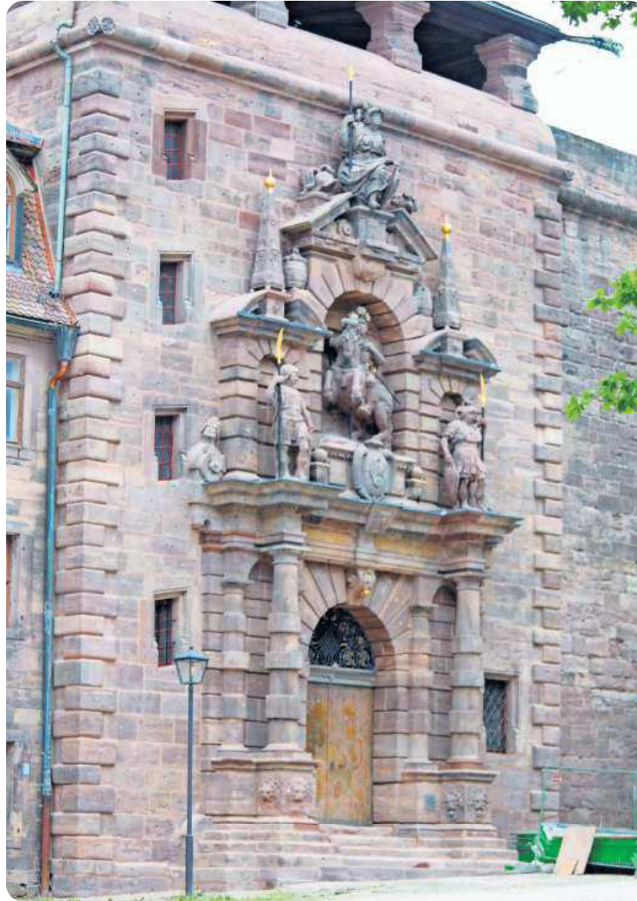
Das Ergebnis der Rettung war den Peter-Parler-Preis wert: Dauerhaft für viele Jahrzehnte soll das Christiansportal wieder den Kasernenhof der Plassenburg schmücken. Jahrelange Planungen und Arbeiten vor Ort und in der Werkstatt waren für die Steinmetze von Monolith notwendig, um die Sandsteinarbeiten des Prunkwerks aus wieder instand zu setzen und für künftige Generationen zu retten.
