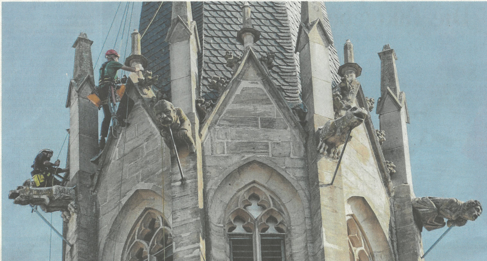
Seilgestützte Reparaturarbeiten laufen seit Montag am Turm der Bad Kissinger Herz-Jesu-Kirche. Die regelmäßigen Überprüfungen des Turms in schwindelnder Höhe sind laut Kirchengemeinde unabdingbar. FOTOS: SIEGFRIED FARKAS
