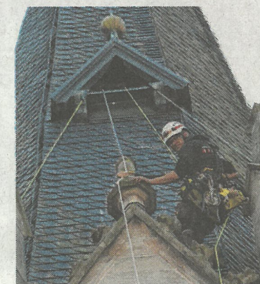
Seilgestützte Reparaturarbeiten laufen seit Montag am Turm der Bad Kissinger Herz-Jesu-Kirche. Die regelmäßigen Überprüfungen des Turms in schwindelnder Höhe sind laut Kirchengemeinde unabdingbar. FOTOS: SIEGFRIED FARKAS
