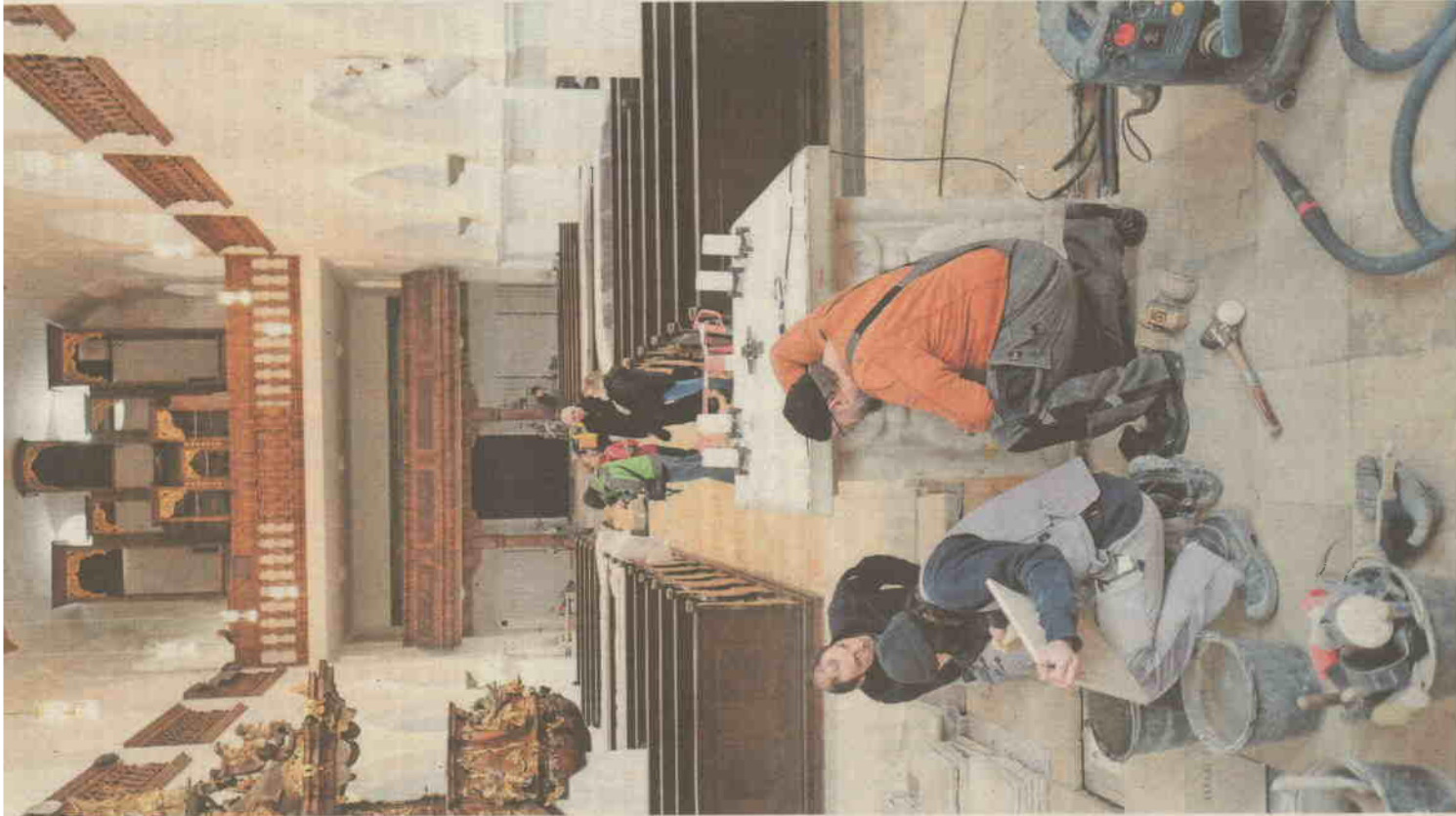
Im Bereich vor dem Hochaltar tauschen die Handwerker einzelne der Solnhofner Platten aus. Der Blick in die Kirche zeigt den Fortschritt der Sanierung.
